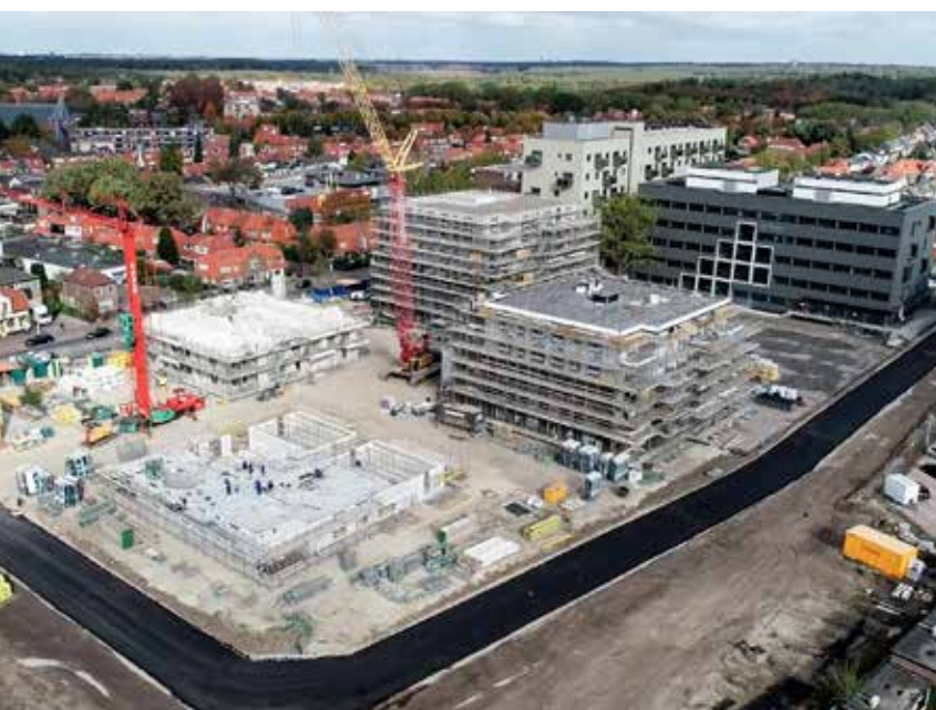
Bouwoverzicht vier appartementengebouwen Lucentterrein.
