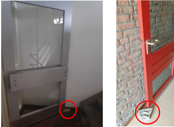
Figuur 7.3 Deuren in geopende stand vastgezet
